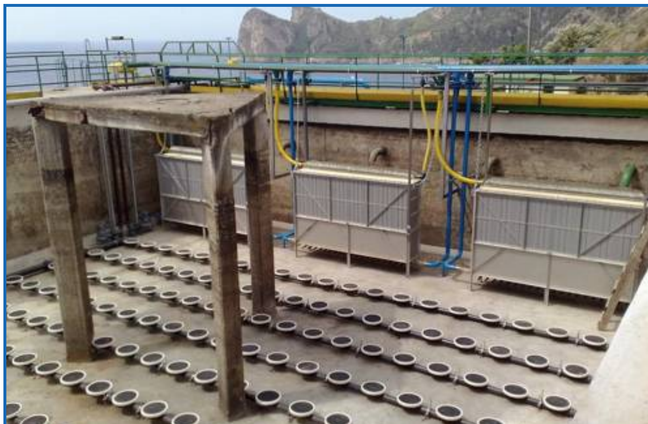
▲ Foto 1 - Installazione di tre moduli Kubota ES200 a membrana piana nel bioreattore di Nerano
